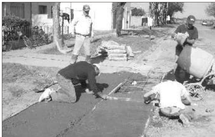
Badenes de desagüe, una importante obra que mejora la calidad del Barrio Belgrano.
