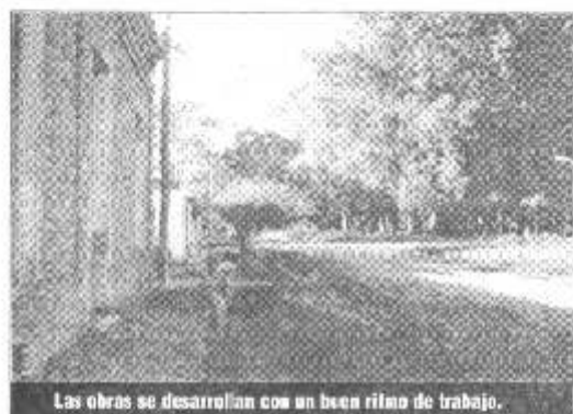
Las obras se desarrollan con un buen ritmo de trabajo.
